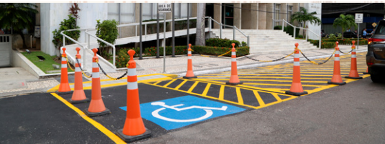
Foram reformadas rampas de acesso, com sinalização e rebaixamento de piso
